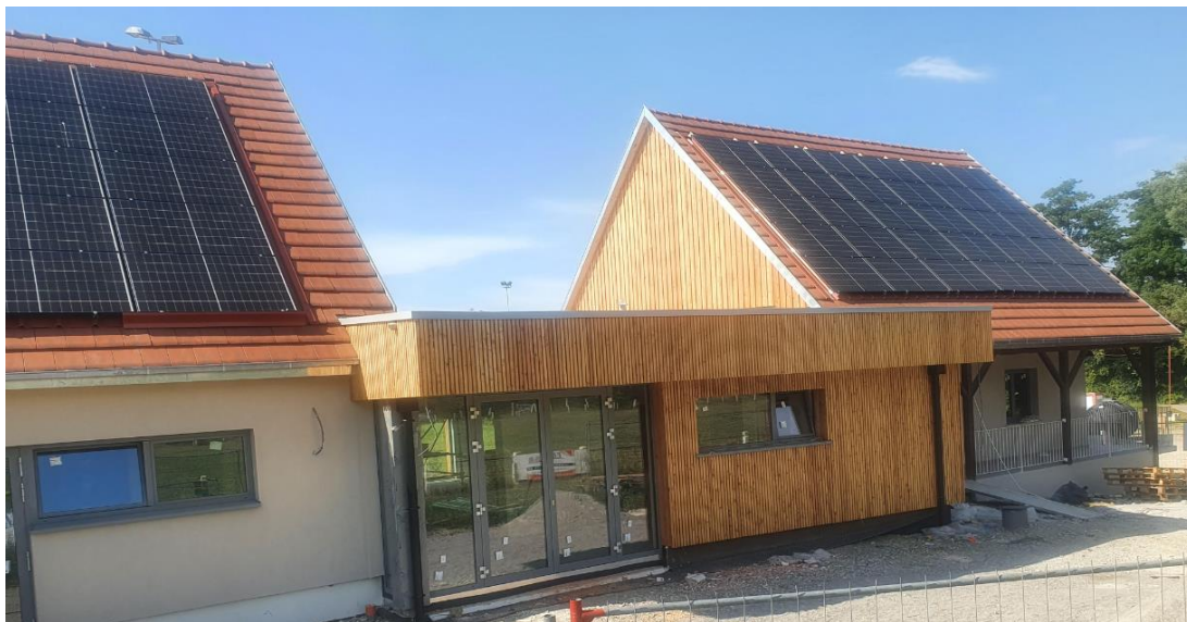
Les panneaux photovoltaïques posés sur les locaux du club-house/salle communale en travaux.
