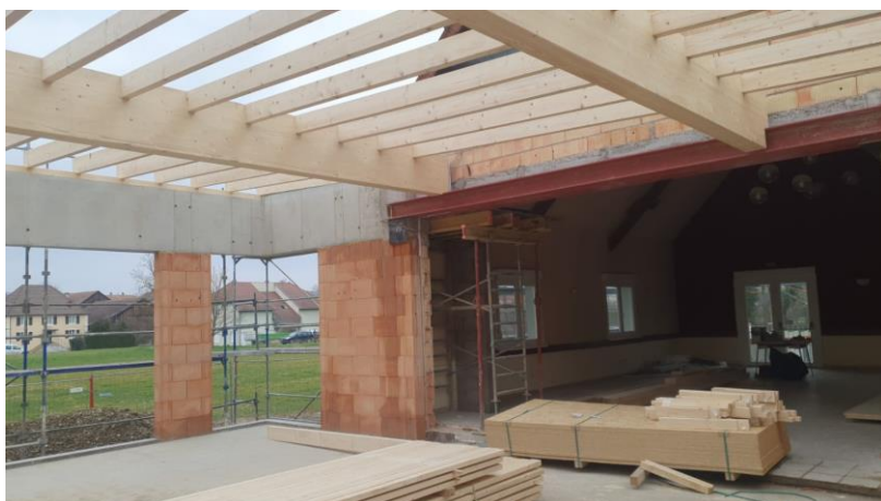
Travaux de charpente, mars 2025
