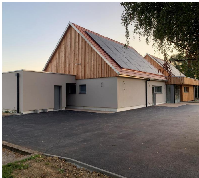
Les bâtiments bénéficient d'un récupérateur d'eaux de pluie, d'un équipement d'assainissement autonome et de panneaux photovoltaïques.
