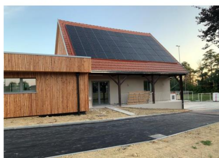
Les bâtiments bénéficient d'un récupérateur d'eaux de pluie, d'un équipement d'assainissement autonome et de panneaux photovoltaïques.
