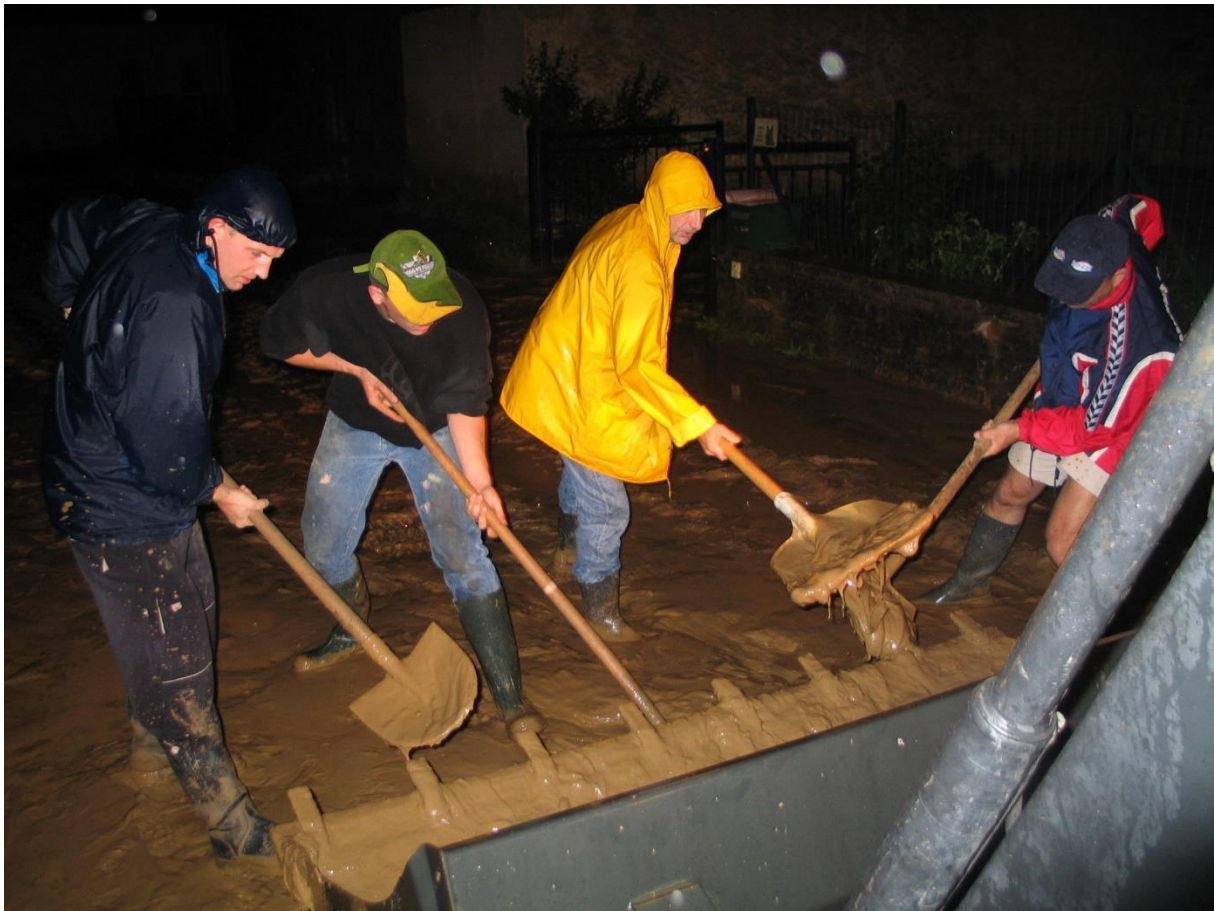
Coulée de boues
