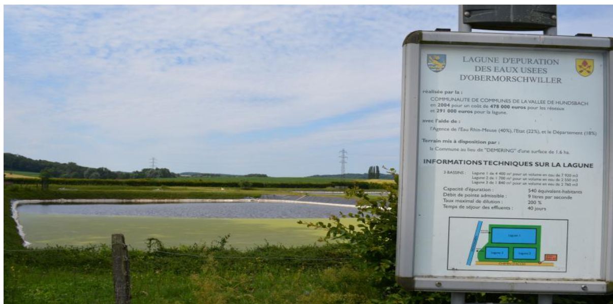
Lagune d'épuration des eaux usées
