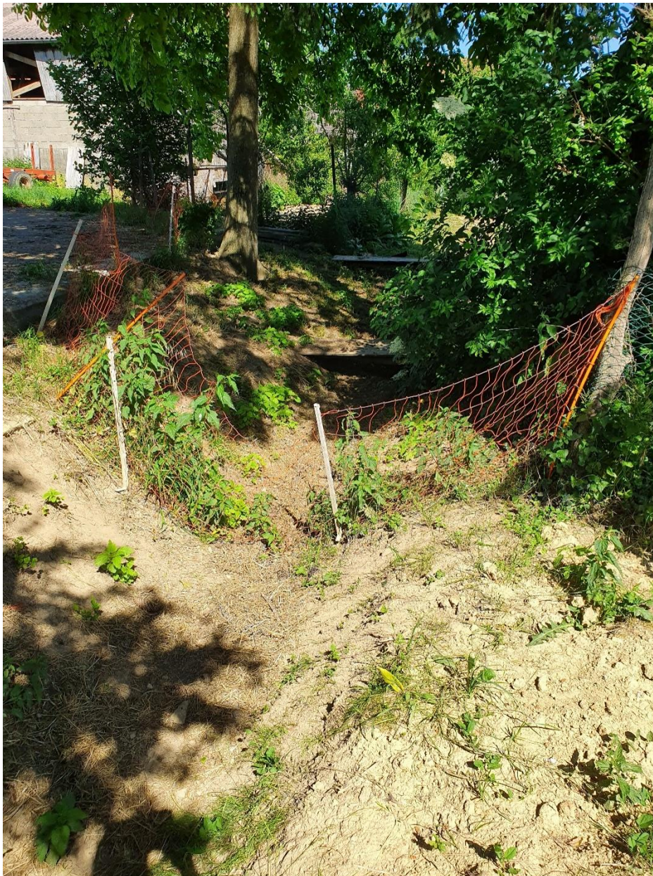
Fossé communal avec réceptacle
